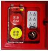
GST-LD-8316H 手自动转换装置（以下简称转换装置），用于控制气体灭火系统在手动状态和自动状态之间的转换，同时还有紧急启动和停动功能。通常安装在保护区门口便于操作的位置，当有人员进入被保护区域时，可通过转换装置将系统置于手动模式，以禁止系统的联动启动；当无人员在被保护区域时，可通过转换装置将系统置于自动模式，以便火灾报警系统能自动联动气体灭火。
